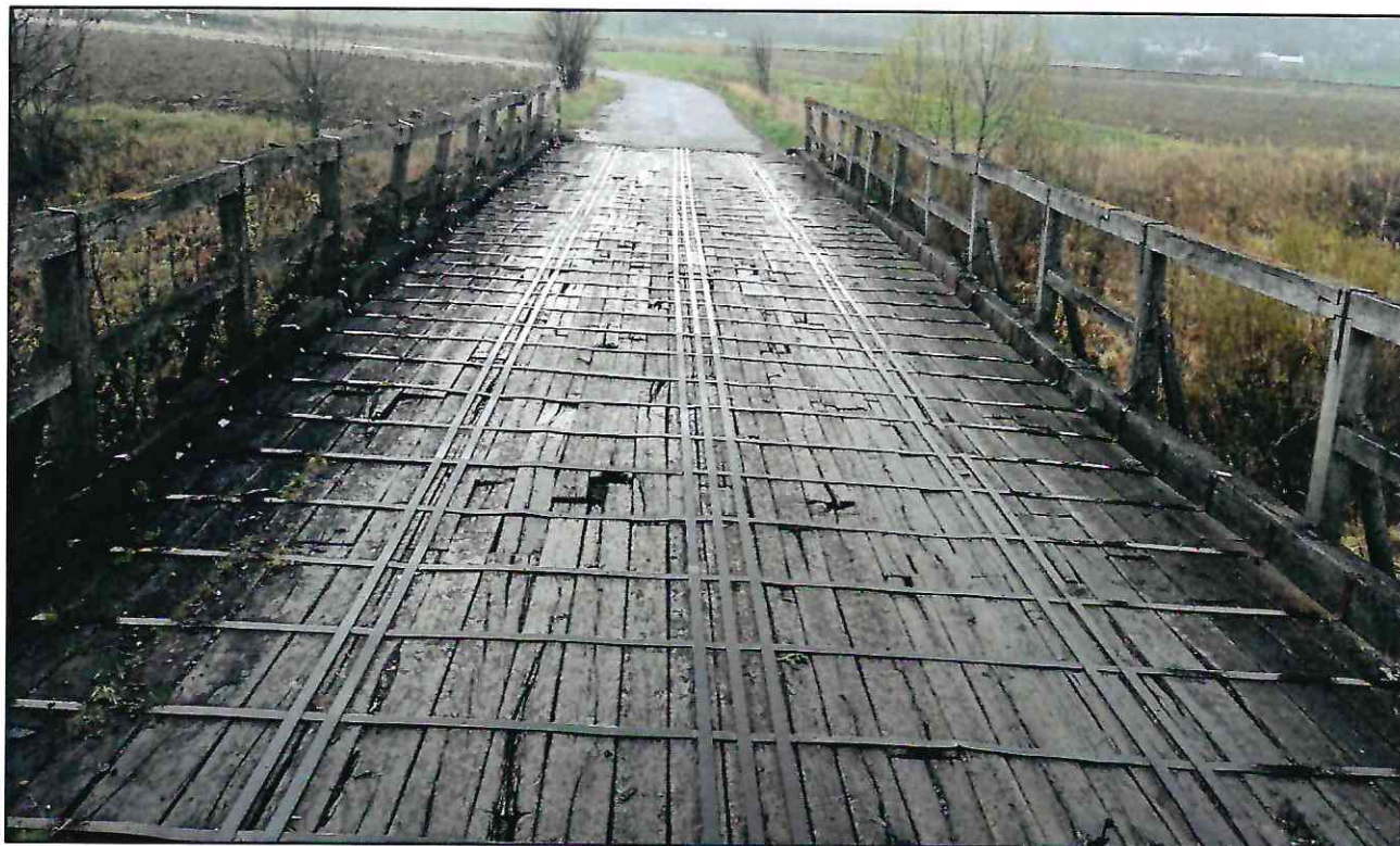
Foto. 2 – Calea pe pod cuprinde o parte carosabilă fără trotuare pietonale
