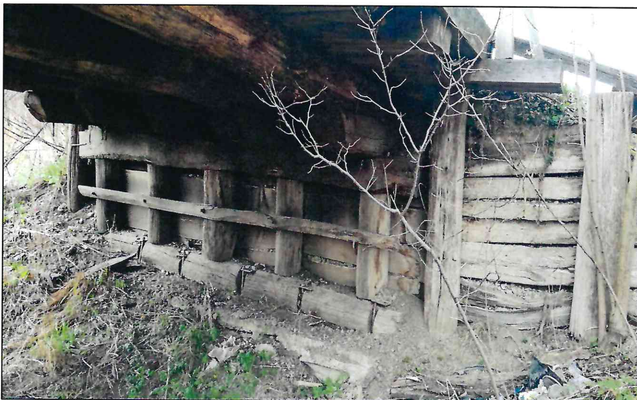
Foto nr. 6 - Degradarea pilotilor si a dulapilor din lemn din spatele culeelor
