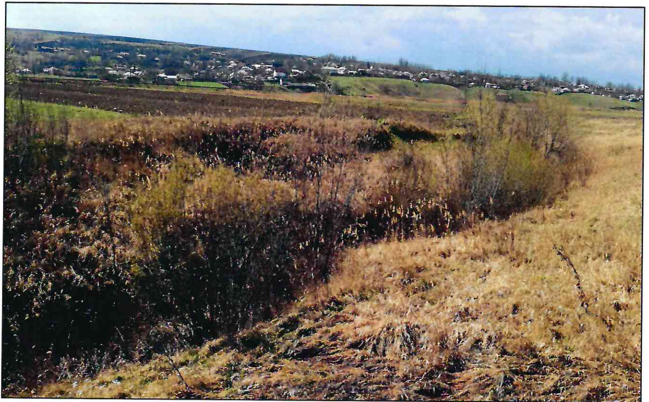
Foto. 9 – Ruperea malurilor si căderea terasamentelor in albie
